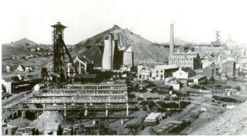
Charbonnage du Gosson-Kessales. Puits 2. Montegnée
